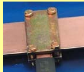
Imagen de unión de barras de cobre con anchos diferentes
