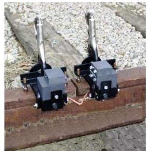
ILUSTRACION DE FORMA DE APLICACION DE MOLDES Y ACCESORIOS EN CONEXIONES A RIELES FERROVIARIOS
